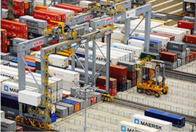
Kuva: Kalmar automatic stacking cranes, DP World, London Gateway
